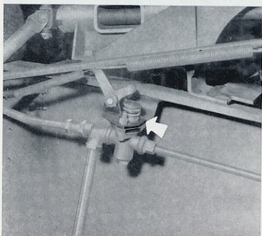
08-18 - Wartung des Betätigungsventils des Ganguntersetzers. Chassis VER- CORS.
